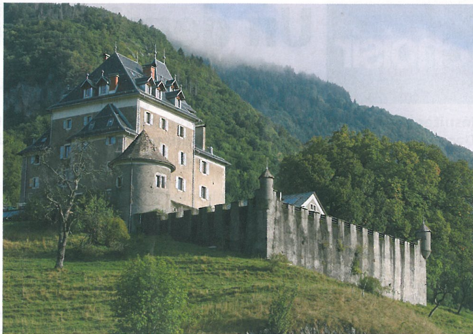
Le château de Saint-Jeoire, côté jardin; et côté cour, en plein chantier.
